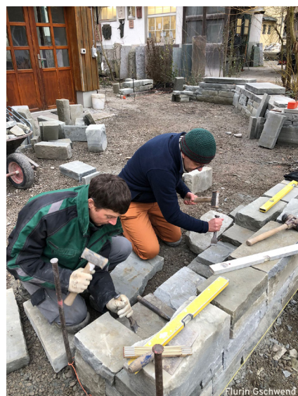
Auch der Chef packt mit an: Markus Bürgisser geht dem Gärtner beim Bau der Trockensteinmauer zur Hand.
