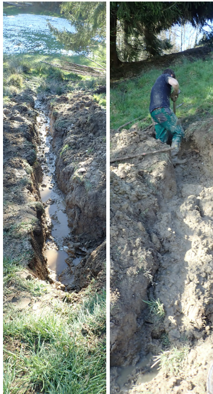
Quelfassungen, Leitungen, Rohre - für die Aufwertung in Heimenhofen wurde alles durch Handarbeit entfernt.
