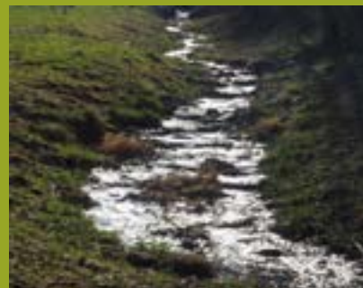
Der ausgedolte Chogebach fliesst aus dem Lengwiler Grossweiher wieder frei zum Bodensee
